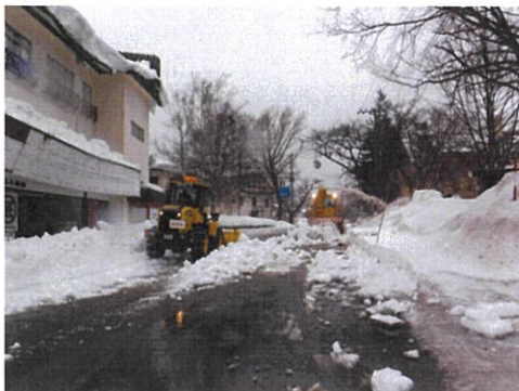
除雪委託事業（生活道路）
