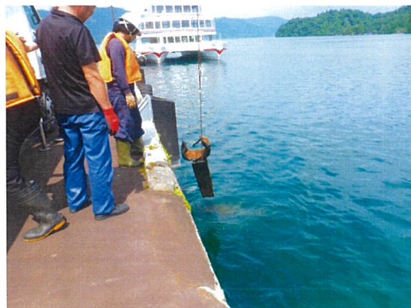
栈橋付近からの工事残材引き上げ
